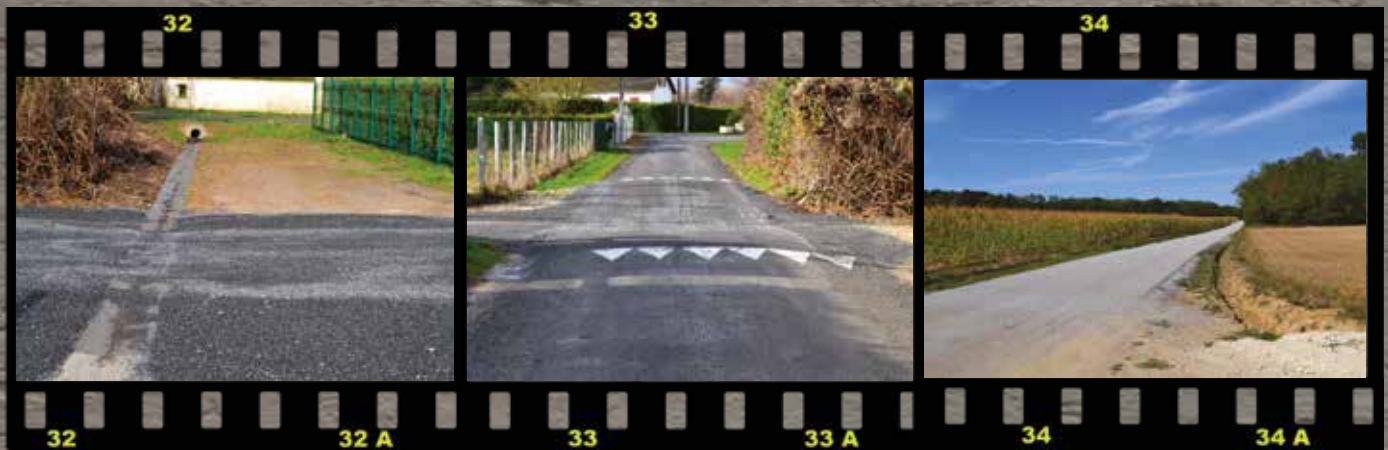
32 32 A Ecoulement des eaux dans la Rue de l'ancienne gare
